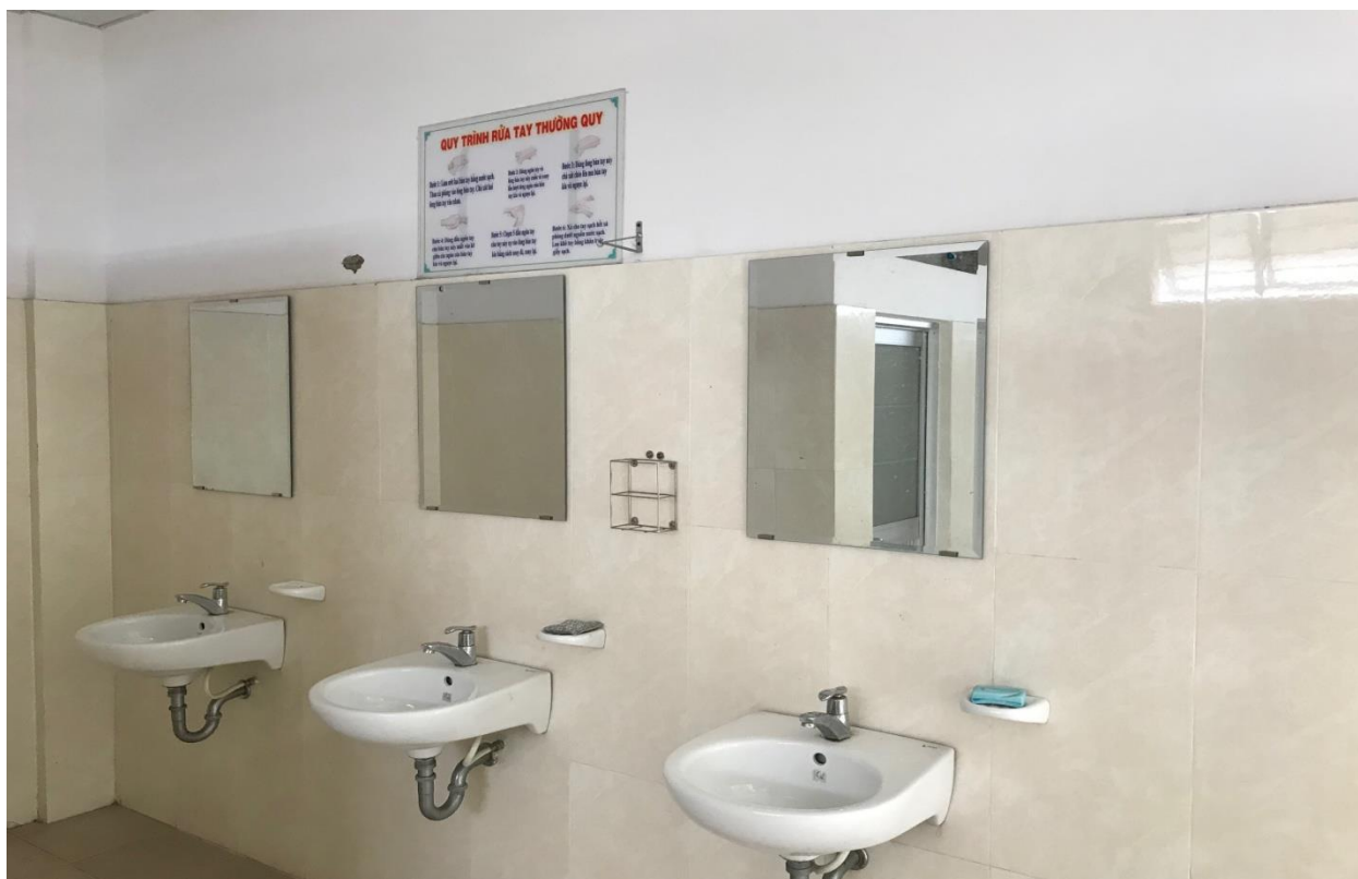
Ảnh nhà vệ sinh Nam của trường THPT Phước Kiển
